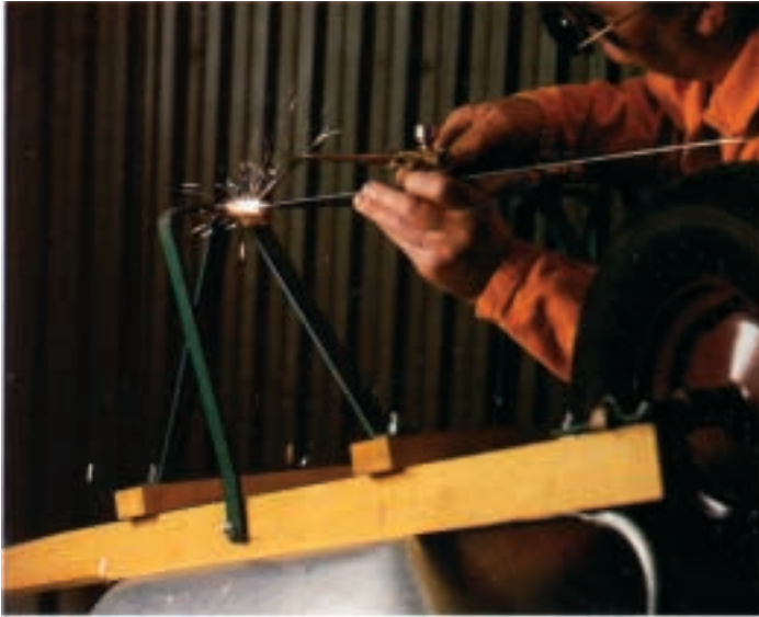
Gasschweißen einer Stahlstütze. Schweißeinsetzung: 2–4 mm.
