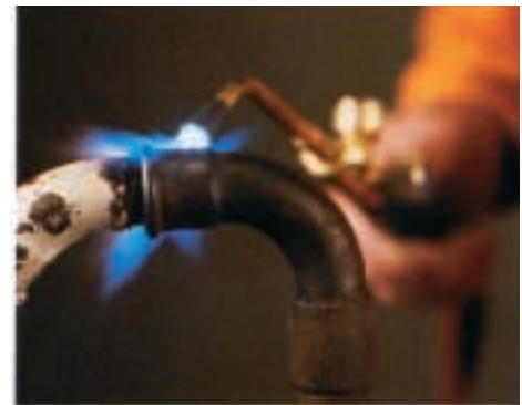
Anwärmen zur Lockerung einer Rohrverschraubung. Anwärmeinsatz, mehrflammig, 2–4 mm.
