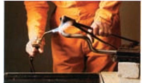
Warmbiegen von Stahlrohren. Anwärmeeinsatz, mehrflammig 2–4 mm.
